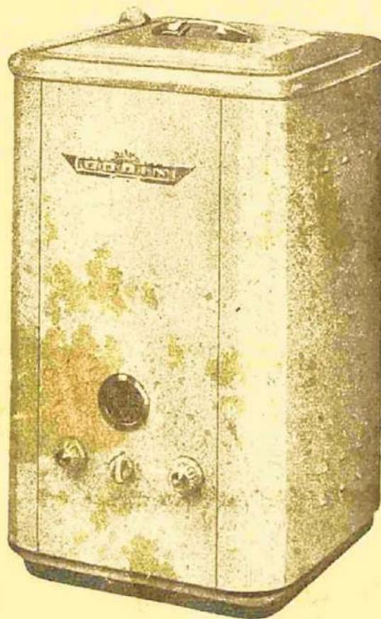
Spécialement étudiée pour les besoins du ménage, elle lave rapidement, économiquement, sans fatigue, sans usure, le linge le plus délicat et les vêtements de travail les plus souillés. Elle chauffe, bout, rince et essore. Vidange par pompe. Chauffage aux gaz. Présentation extérieure acier émaillé, blanc vitrifié. Intérieur de la cuve émail vitrifié à 900 degrés.
